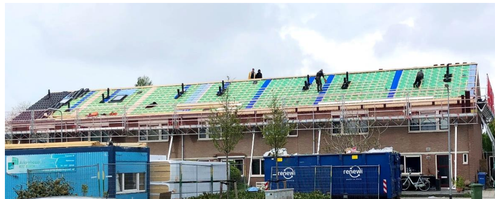
Foto boven: dakvervangning in uitvoering
