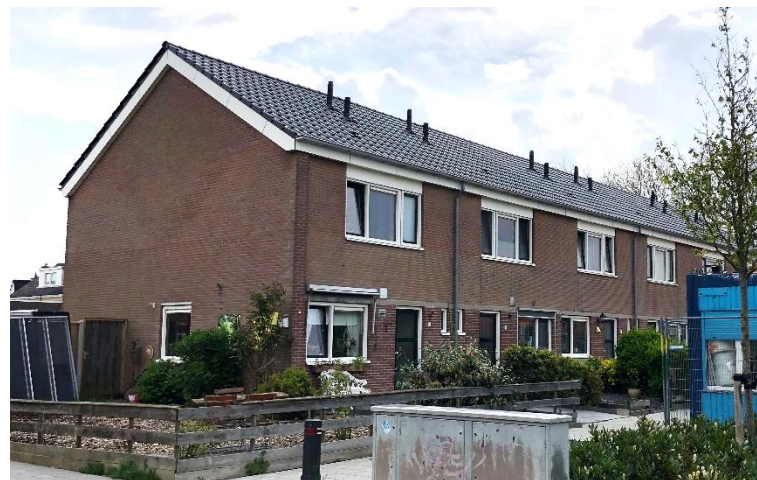
Foto onder: dakvervangning van woningblok gereed
