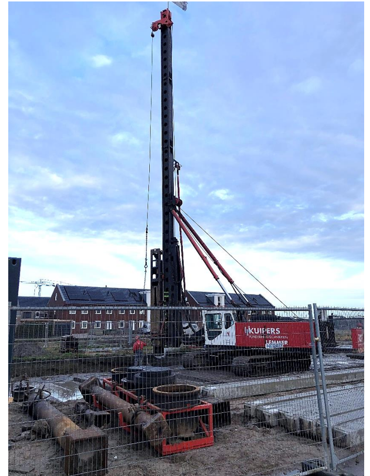
Foto: Het slaan van de eerste paal op 14 januari 2020
